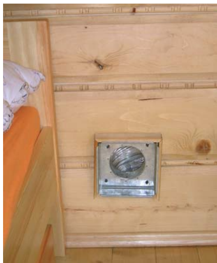
obr. 3 – Výstupná mriežka z krbu do spálne ide cez drevenú stenu a navyše ústi pri drevenej posteli
